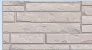
新築時/既存の外壁
